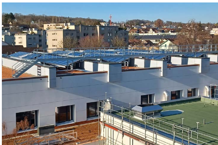
Dachsanierung mit Solarthermie neu
