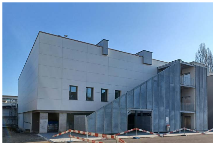
Fassadensanierung mit Anteil Hochwasserschutz – Höhenivellierung
