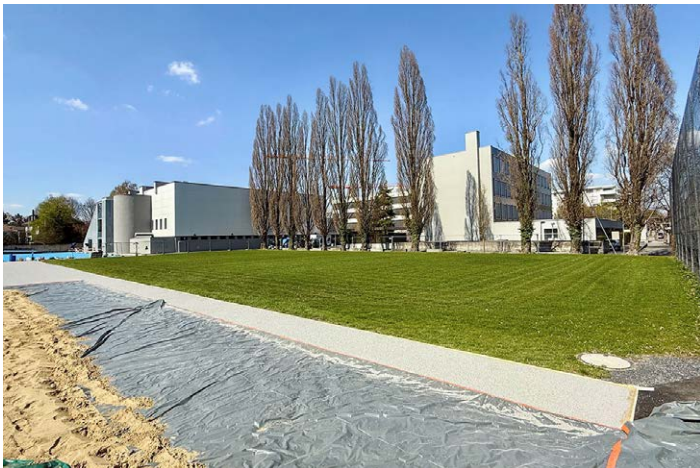
Wiederherstellung Spielwiese nach Erdsondenbohrung inkl. Hochwasserschutzmassnahmen
