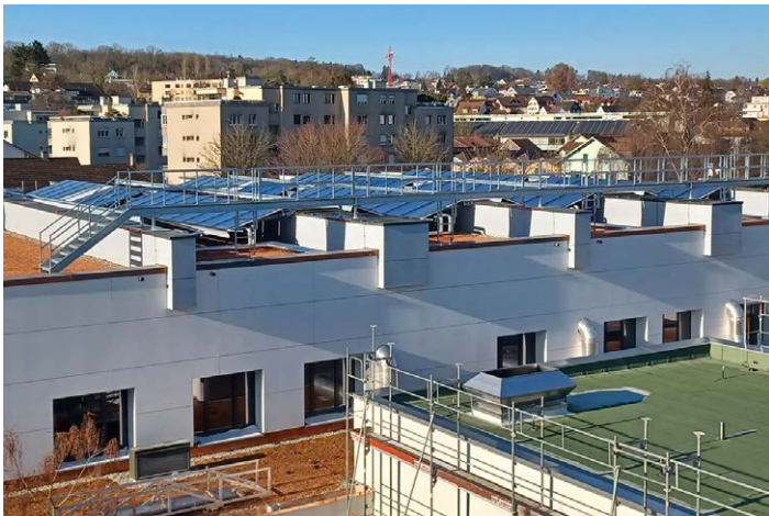
Dachsanierung mit Solarthermie neu
