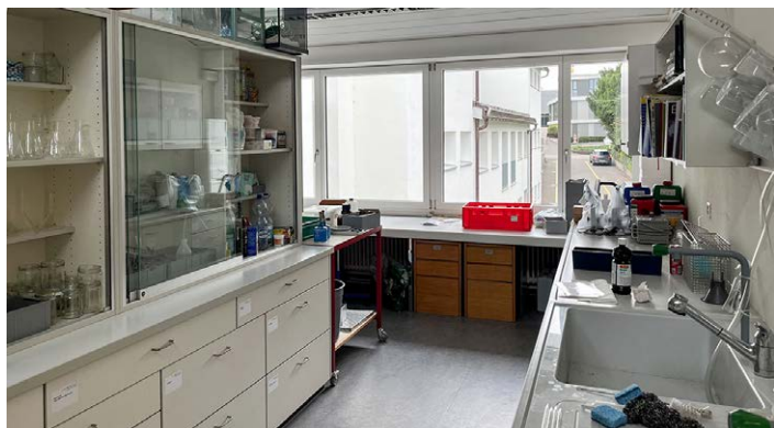
Vor der Sanierung
