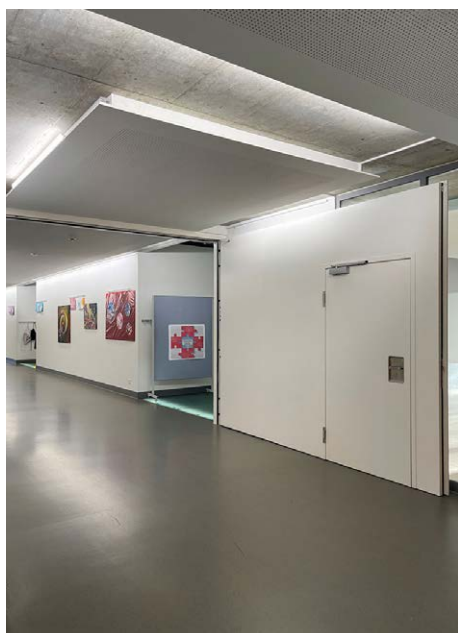
Nach Einbau der Fluchttore und der Fluchttür Turnhalle
